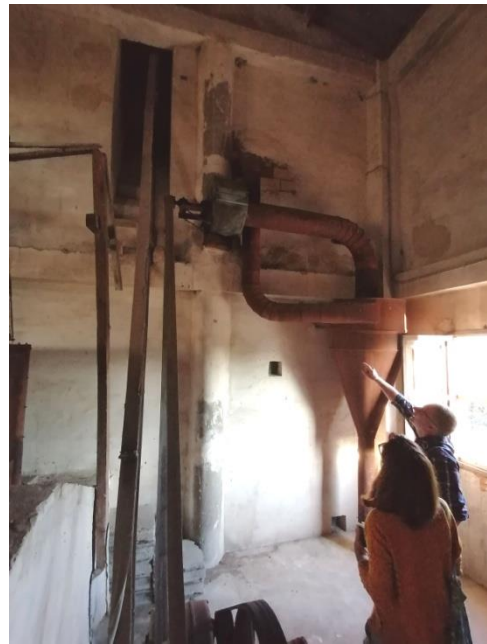
Sala de maquinària interior
