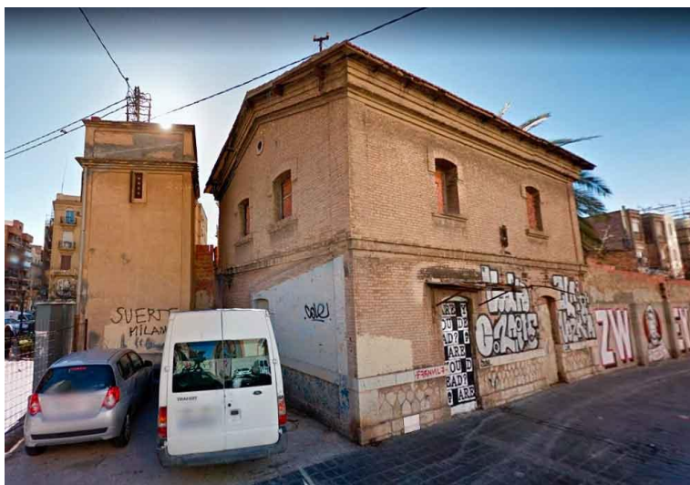
Casa de guardabarreres en el carrer Rafael Contreras Juesas. Font: La Valencia Insólita 13
