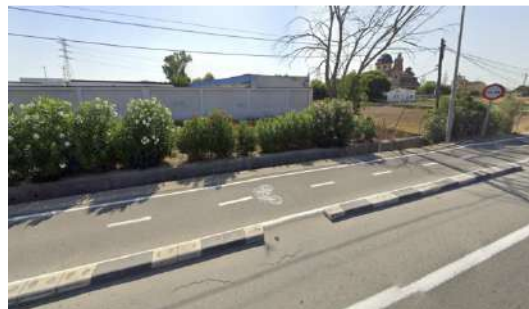
Carril bici paral·lel a la Carretera del Riu
