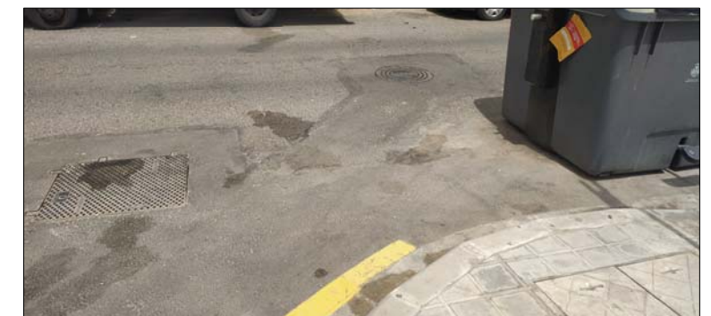
POZO CONEXION NUEVO TRAMO SANEAMIENTO
